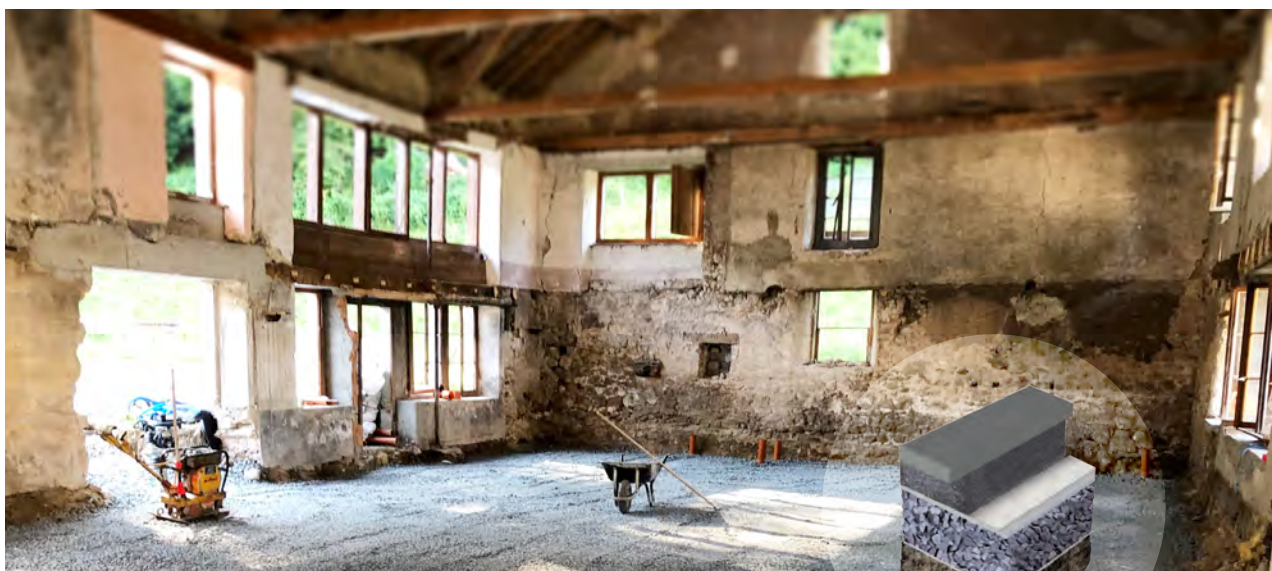
Rénovation d'une maison villageoise
